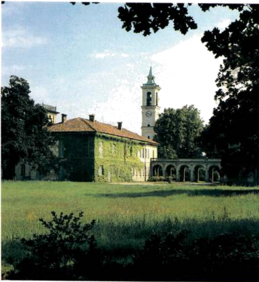
L'ala est della Villa Trivulzio ed il portico che unisce i due corpi paralleli della villa.
