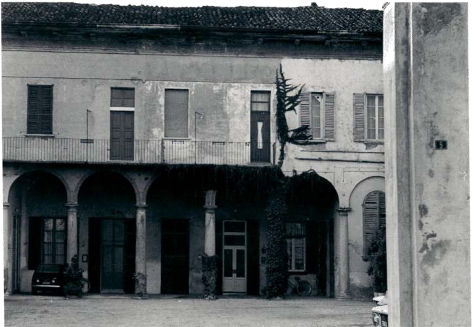
Il porticato è rimasto l'unico elemento a testimoniare il prestigio della ex Villa d'Adda.
