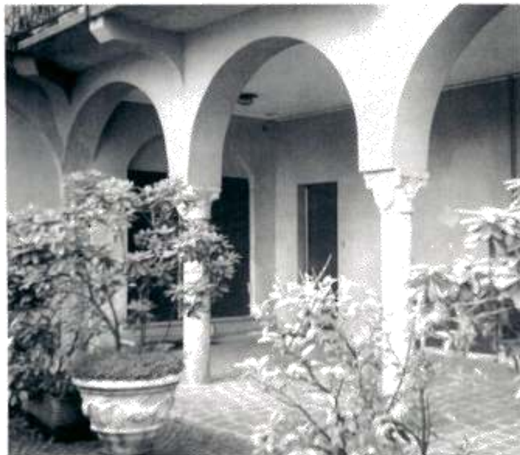
L'elegante portico della ex casa de Capitanei, dove spiccano i capitelli delle agili colonne in granito.
