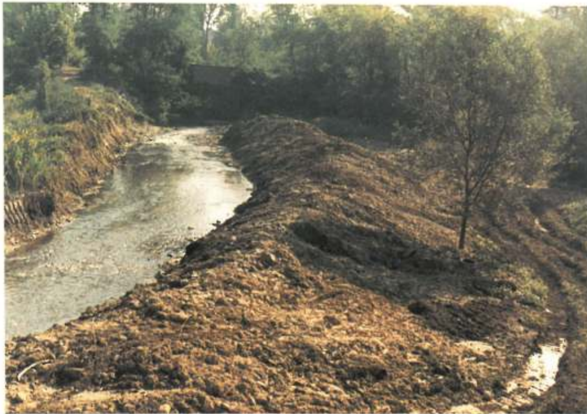
1983 - Bonifica degli argini del Molgora.
